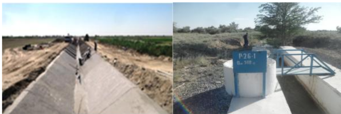
Рисунок 2 –Бетонирование внутрихозяйственного канала (Махтааральский район) и водомерное устройство на участковых каналах (Туркестанский район)
